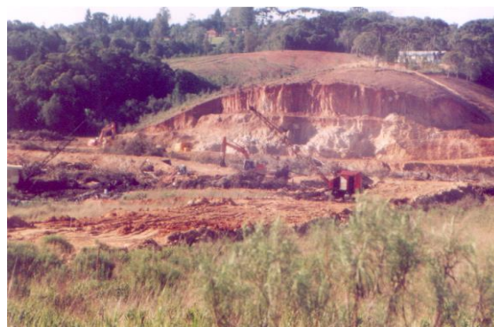
Construção da Barragem Piraquara II / 2003
