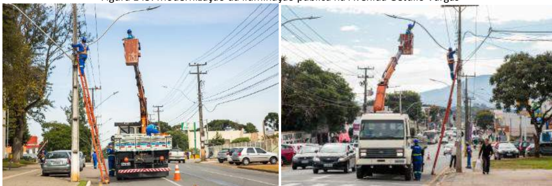
Figura 145: Modernização da iluminação pública na Avenida Getúlio Vargas
