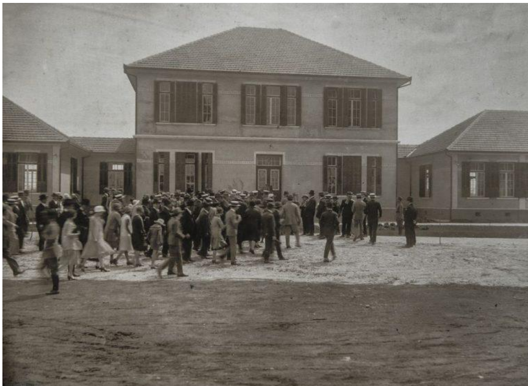
Figura 3: Hospital São Roque.
